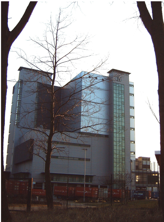
Abbildung 3: Kaffeelegerei Neumann Gruppe: 15% der Weltermenge von Kaffee werden hier verarbeitet. Verlagerung aus der Hafencity zu Lasten der Stadt von 50 Mio. € und Neubau auf der Hohen Schaar, wobei 30 ha hochwertiges Brachland und eine Mövenbrutkolonie versiegelt wurden.
