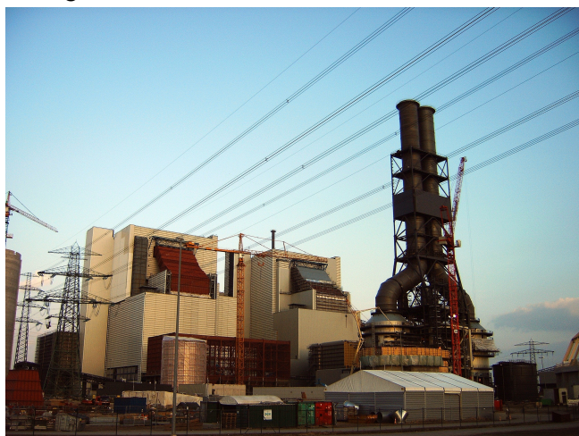
Abbildung 8: Kraftwerk Moorburg im Bau; Foto RdE
