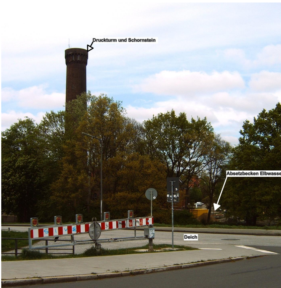
Abbildung 3: Wasserwerk Rothenburgsort; Elbwasser wurde über den Deich in Absetzbecken gepumpt und dann auf den Druckturm
